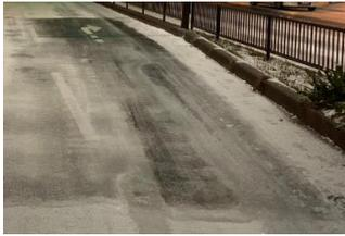
散布直後、ブラック路面が表れる。凝固点降下による作用。
